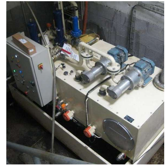
• Centrale de lubrification huile M4-LUBR_HUIL
